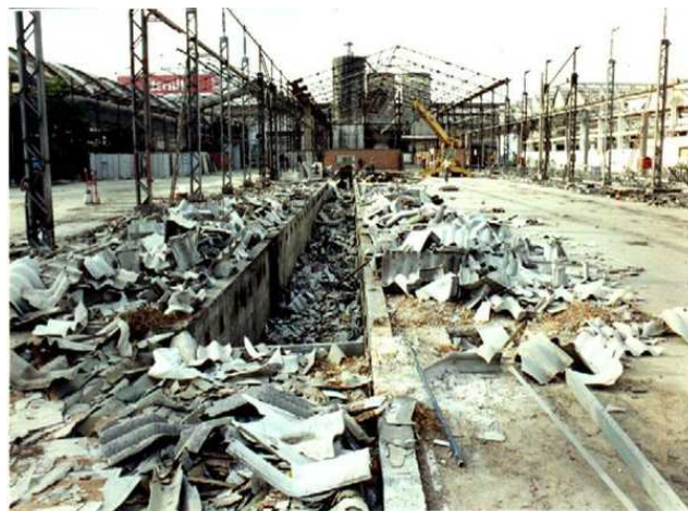
Decommissioning of the asbestos-cement plant in Osasco, São Paulo. Photo: Eduardo Metroviche - Sindicato dos Metalúrgicos de Osasco e Região.
