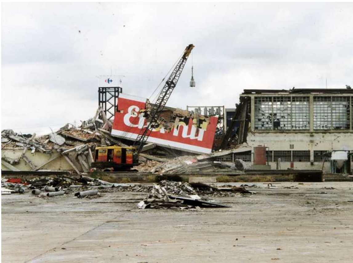
Demolition of the Osasco plant in 1995. Photo: Eduardo Metroviche - Sindicato dos Metalúrgicos de Osasco e Região.
