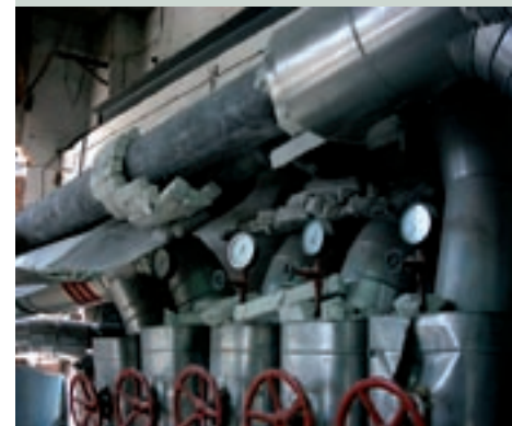
Tubería de amianto rota y expuesta
