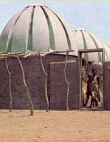
Construcción de viviendas con cemento amianto en Nigeria durante los años setenta
