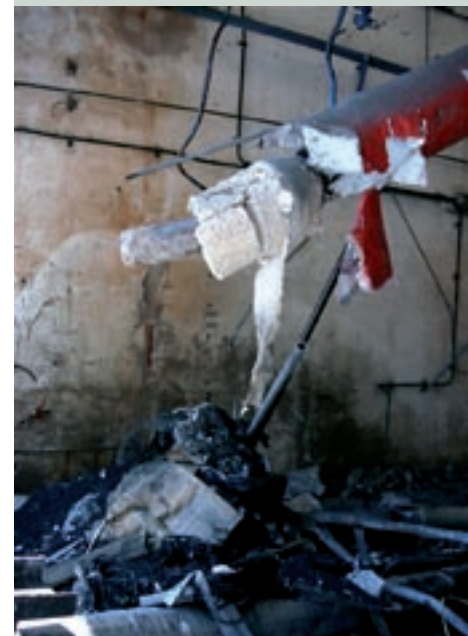
Tuyauterie en amiante cassée et exposée
